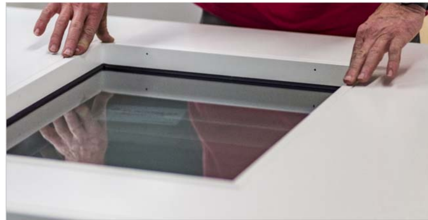
Glaseinbau mit Glasleiste innen
